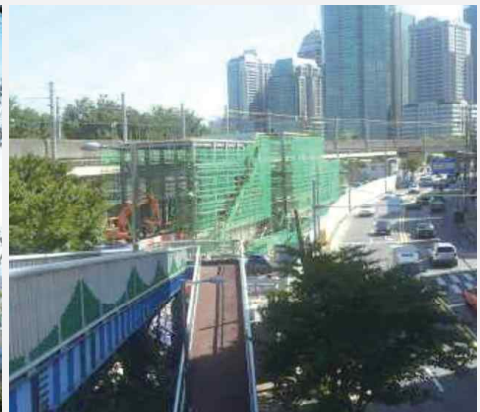
신림 2빗물 펌프장 공사장 전경
