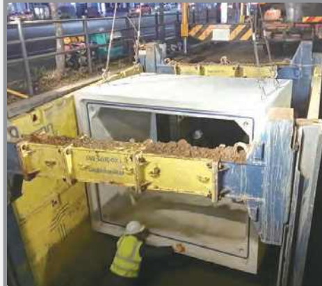
대림배수분구 하수관로 종합정비사업 (조원동 일원)
