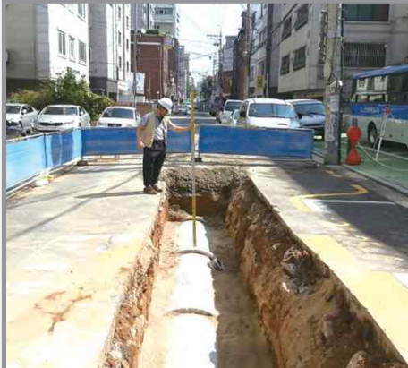
신림4배수분구 하수관로 종합정비사업 (신사, 미성, 조원, 난곡동 일원)
